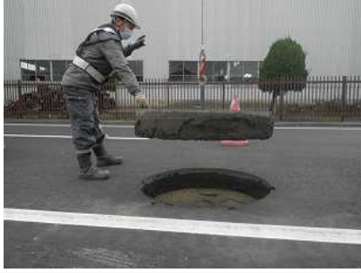
マンホールの後施工における舗装撤去状況
